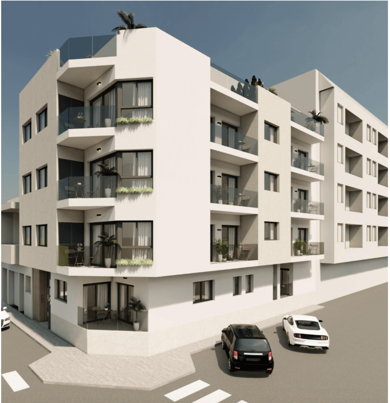
Guardamar del Segura Leilighet i Guardamar del Segura Tilbudsnummer: 32476
